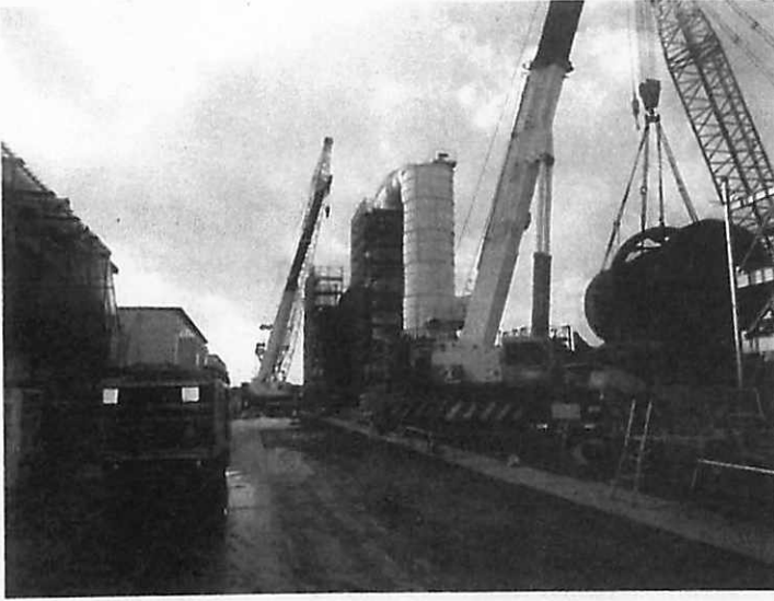
鹿島JVの仮設焼却炉(1号基の建設状況)
