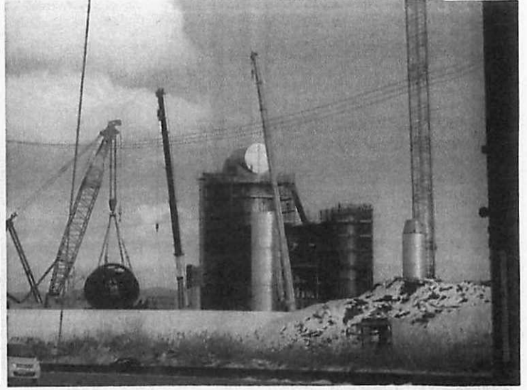
1号基の排ガス施設の建設状況(敷地外から撮影)
